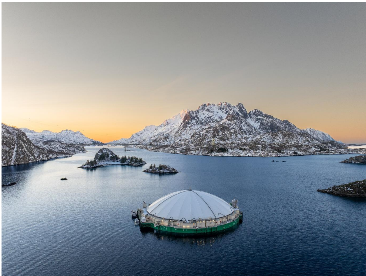
Figur 3. Oversiktsbilde av plassering av enheten, sett fra nordvestlig retning. Foto: Kolbjørn Hoseeth Larssen, Nordlaks.
